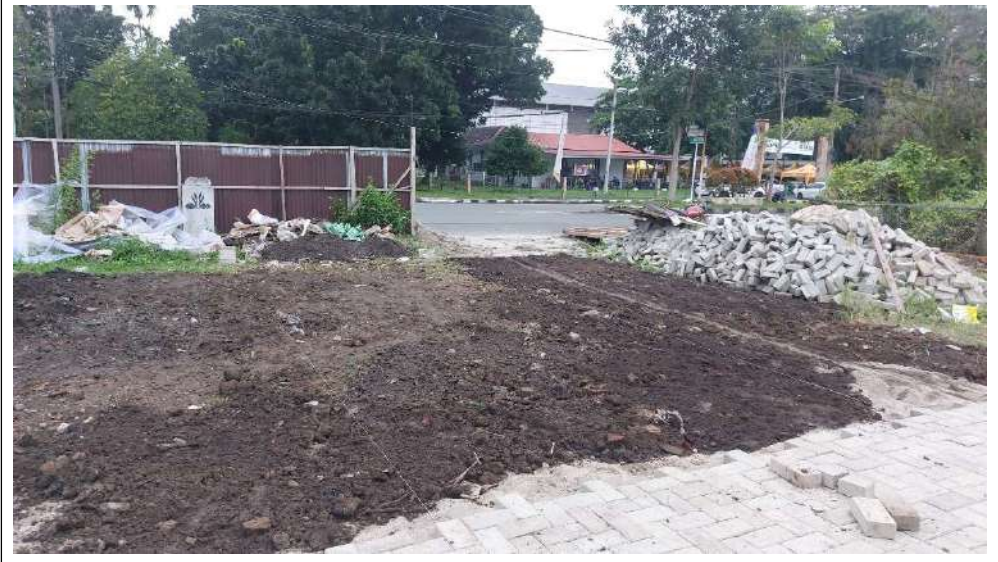
Proses pemasangan granit 60x60 ruangan
