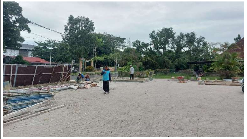
Granit setelah pemasangan
