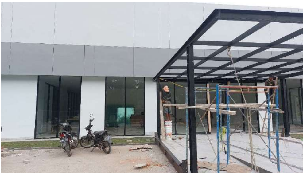
Proses pengecatan baja
