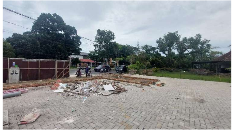
Proses pemasangan bentengan taman
