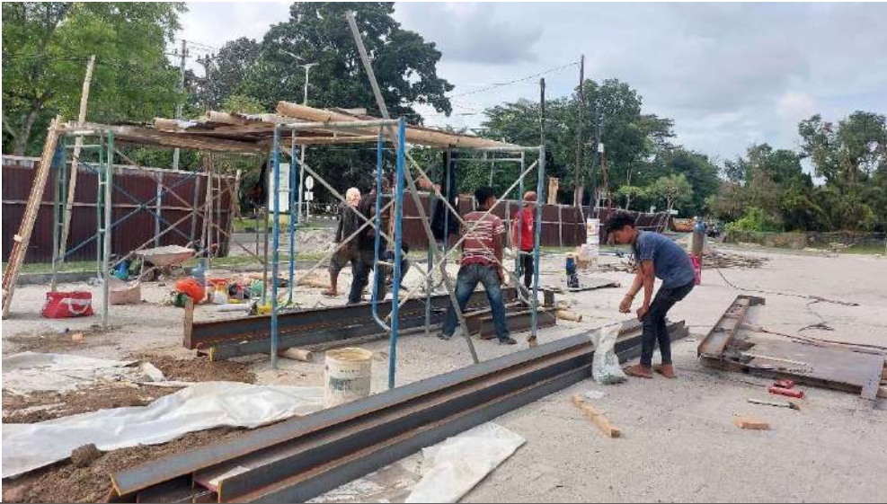
Proses pemotongan baja wf
