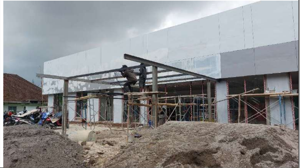
Proses perakitan baja wf
